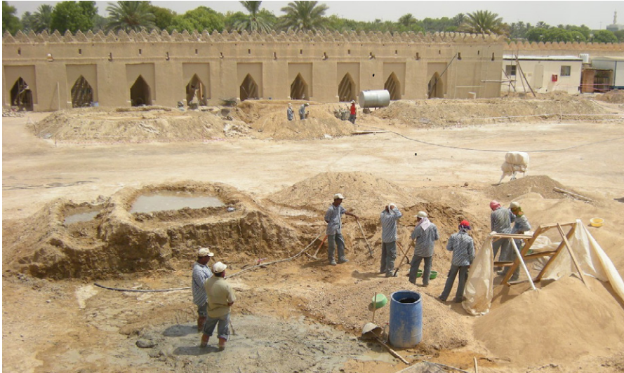
Abb. 2.16: Traditionelles Aufbe- reiten von Baulehm mittels Sieben, Sump- fen und Mauken
