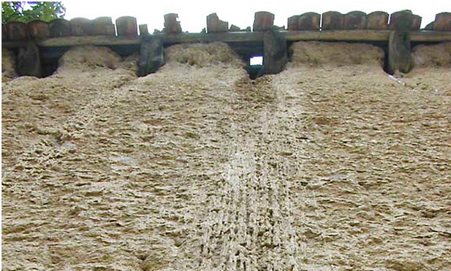
Abb. 2.5: Infolge eines Bauschadens replastifizierter und wiedererhärteter Lehm an der Außenwand einer historischen Massivlehmscheune (Blick nach oben zur Traufe)
